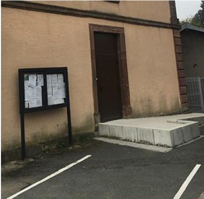
Fourniture et pose d'un bloc porte en aluminium à rupture thermique mettant en œuvre les profilés « SCHÜCO » porte « ADS 60 CH » (dormant, poteau, traverse, ouvrant), conformes aux normes XP p 24-400 pour les profils et XP p 24-401 pour les portes et sous homologation gamme du CSTB.
